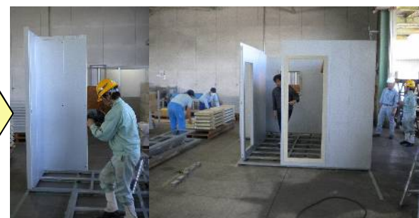
壁パネル建て込み（写真は工場内での仮組状況） 床フレームの上に壁パネルを載せてジョイントします。
