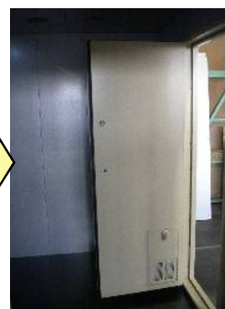
防音ドアを吊り込み
