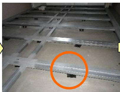
防振マウント+床フレーム （防振マウントで甲板と接触）
